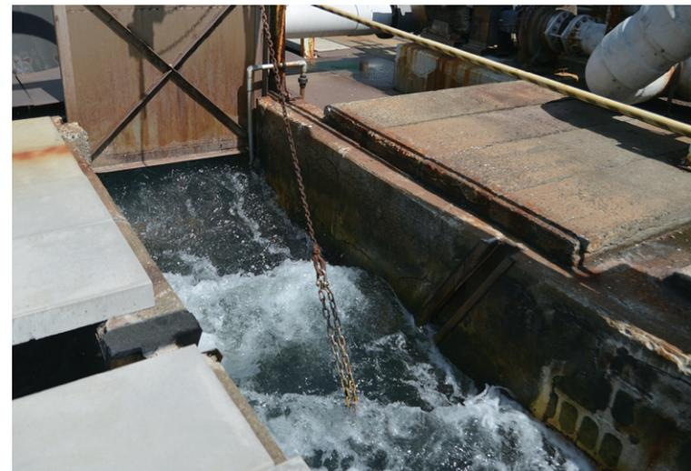
1日10万トンの海水を加工する工場の取水口。
