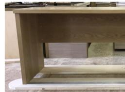
⑥ 補強の背板は、壁コンセントタップが隠れないように、わざと下部を大きく開けています。
