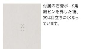
受け金具を壁に取り付ける際は、石膏ボード壁には付属の細ピンで木壁・柱には付属のネジで固定してください。
